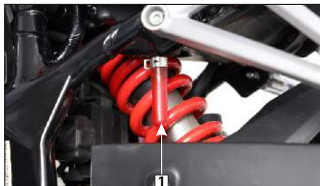
(1) Tubo de drenaje
